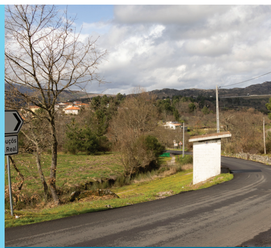
PAVIMENTAÇÃO DA M1231 - FORTUNHO
