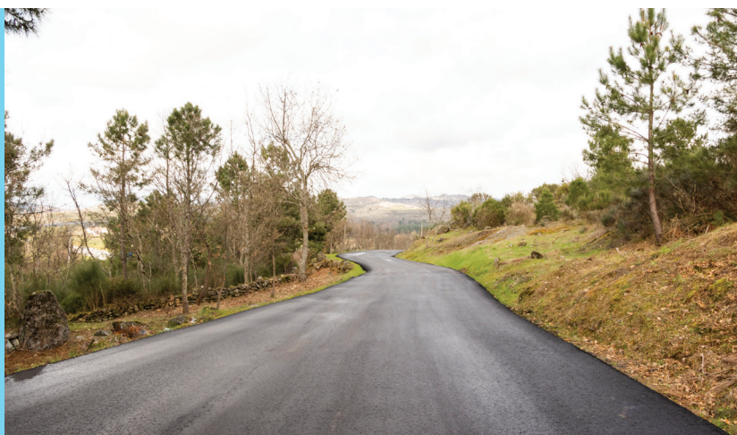
PAVIMENTAÇÃO DA M1231 - FORTUNHO
